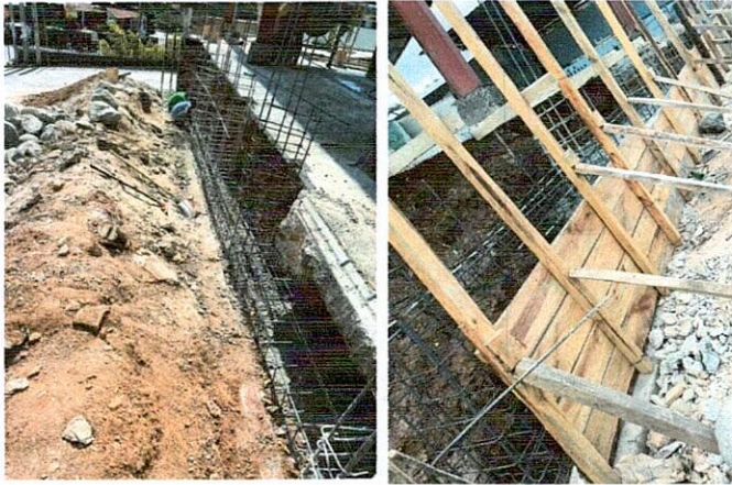
Foto 1: Cimientos del muro de contención, se pueden observar las fundiciones realizadas y el material empleado.
