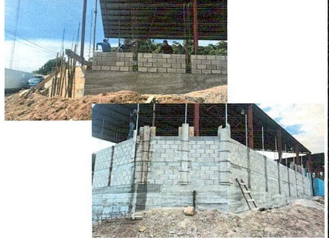
Foto 2: Avance en mejoramiento e instalación del muro de contención.
